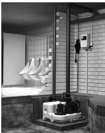
Рис. 97. Пример установки Multilift MD в прямом в подвальном помещении здания
